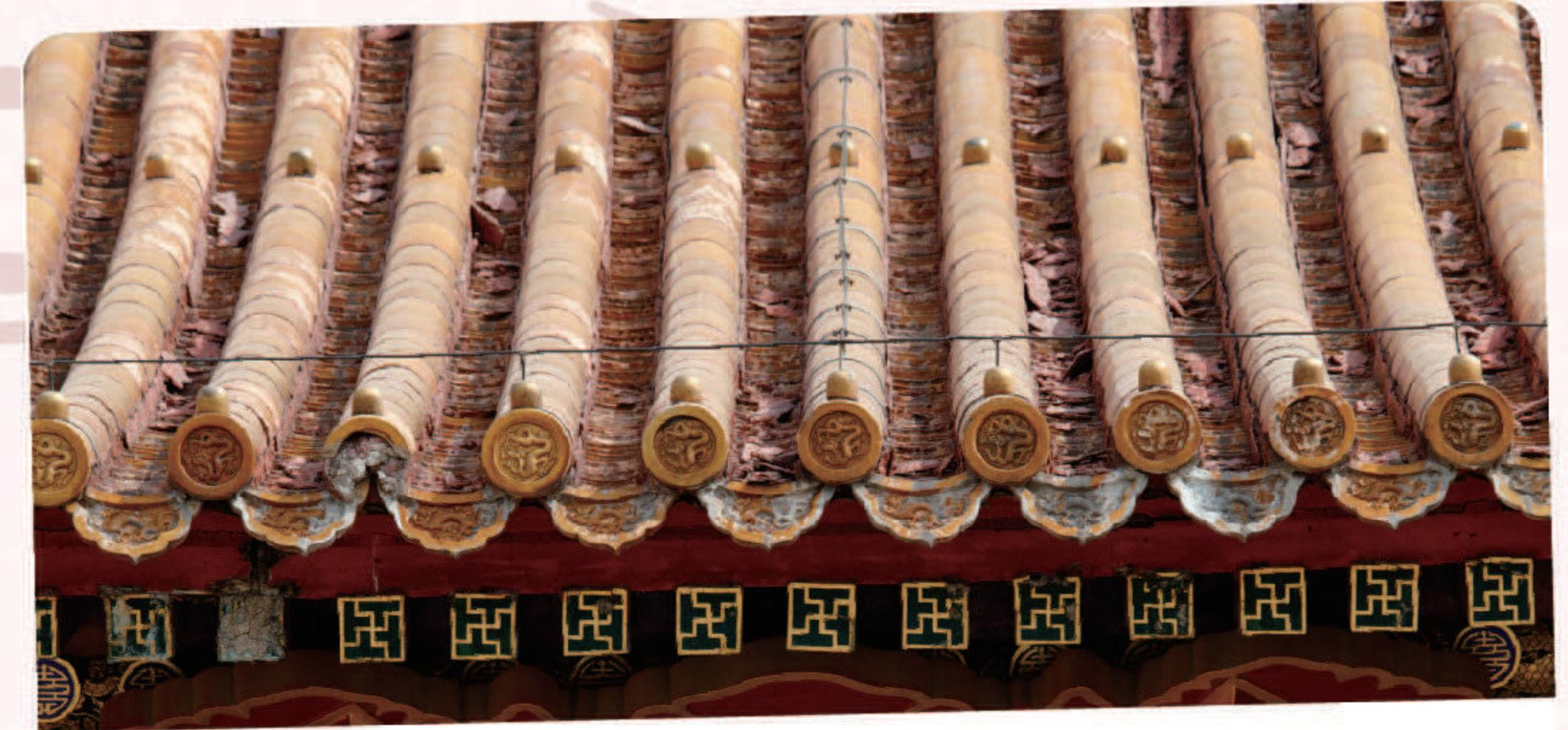
铺设在屋顶上的琉璃瓦，可保护木结构不受雨水侵蚀。
